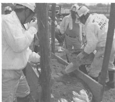
水防工法「せき板工法」実 施訓練の様子
